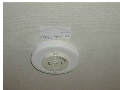
天井引掛シーリング (施工完了)
